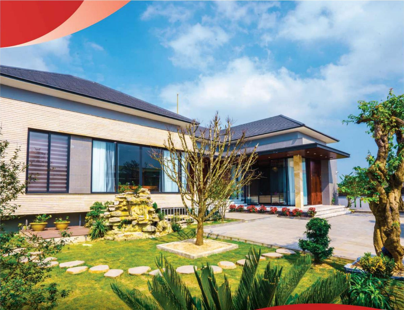
Công trình tại Vinh Linh, Quảng Trị
