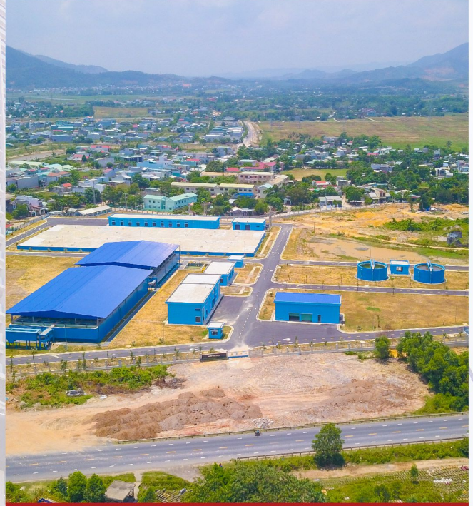
Nhà máy nước Hòa Liên Đà Nẵng
